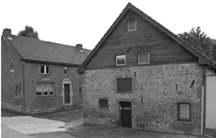
's Gravenvoeren, voorgevel grotendeels opgetrokken uit silex.
